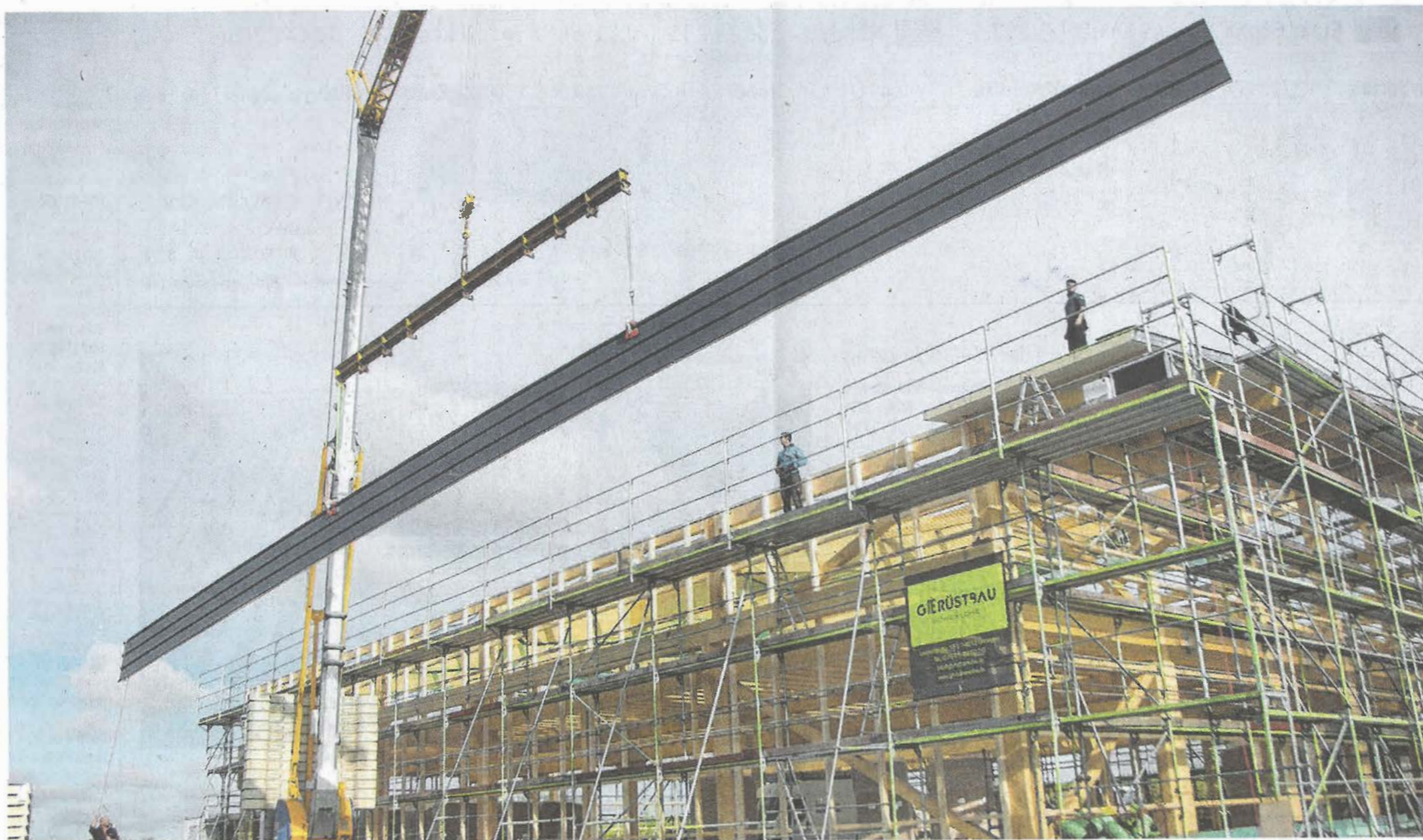
Mit über 26 Meter langen Sandwichelementen wird das Dach der neuen Packhalle gedeckt.
