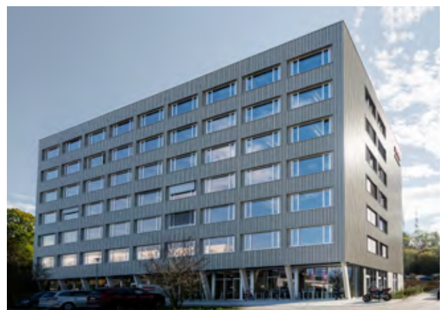
Bauobjekt nach erfolgter Montage der Designprofile
