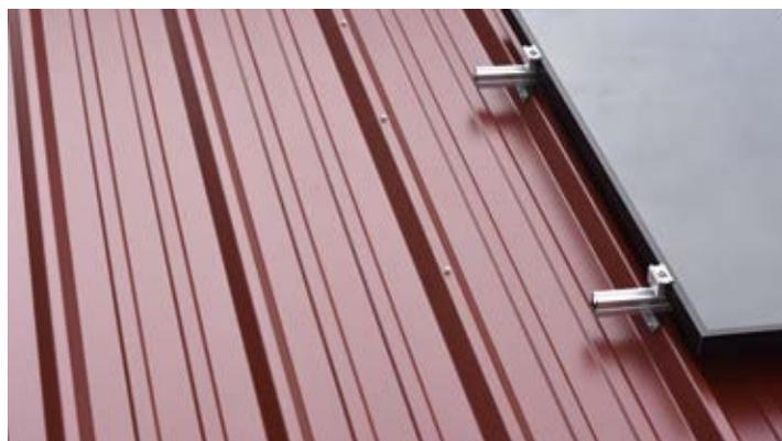
Bei Installation einer Solaranlage wird die Beschichtung in Bezug auf Abrieb- und Kratzfestigkeit noch weiter beansprucht. Unsachgemäße Handhabung von Materialien und Werkzeugen kann hier, bei zu geringer Beschichtung, zu Kratzern führen und somit das Dach nachhaltig korrosiv schädigen.
